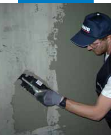
Nanoszenie Planitop 200 na podłoże betonowe
