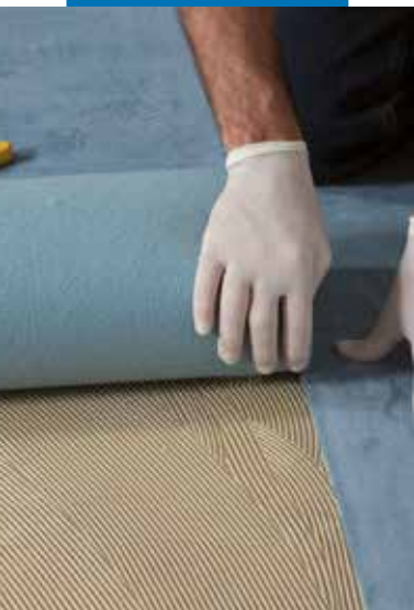
Montaż wykładziny dywanowej
